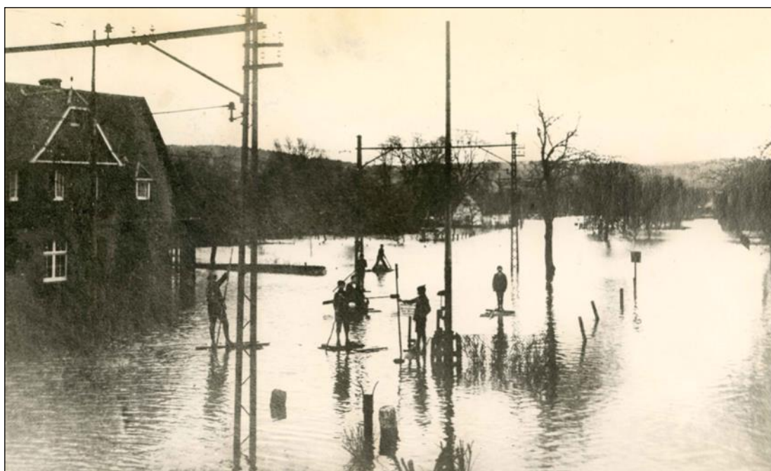
Im Januar 1926 ist die Station „Limperich“ durch hochdrückendes Grundwasser überschwemmt. Grund dafür ist das Hochwasser des Rheins. ■ Foto: Stadtarchiv Bonn
