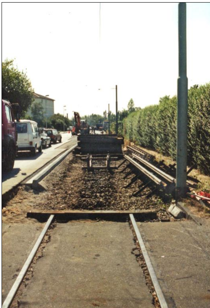
Gleisrückbau in der Wertstraße am 6. August 1994. ■ Foto: Michael Much
