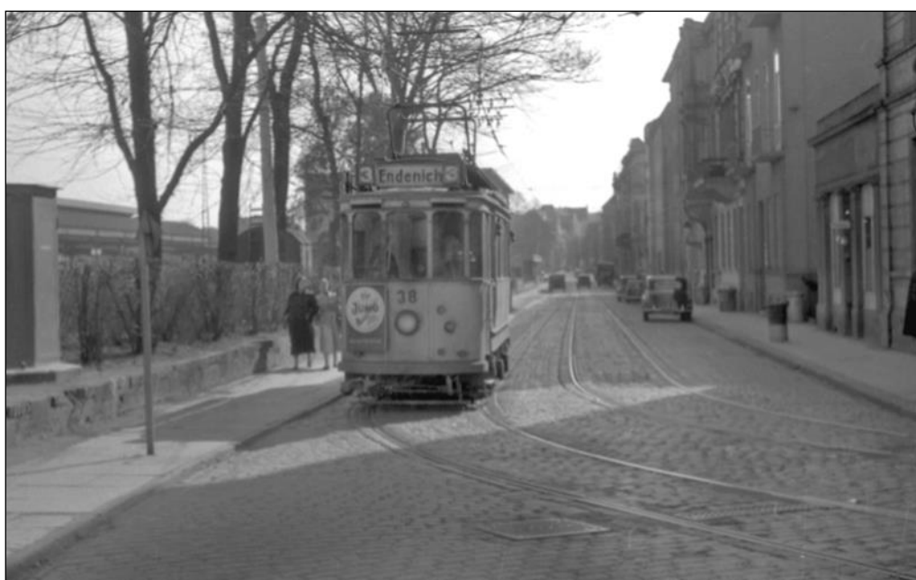
Unten rechts sind die Stelleinrichtungen der abzweigenden Weiche zur Meckenheimer Allee zu erkennen. Hier zweigte die Strecke der Linie 4 nach Poppelsdorf ab.
